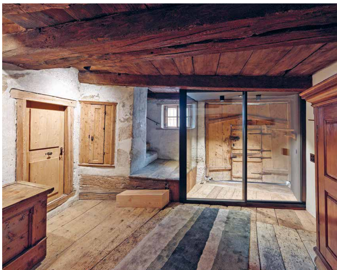
Neu im Sulèr ist der gläserne Windfang – eine thermische Trennung, die die alte Eingangstür wahr.
