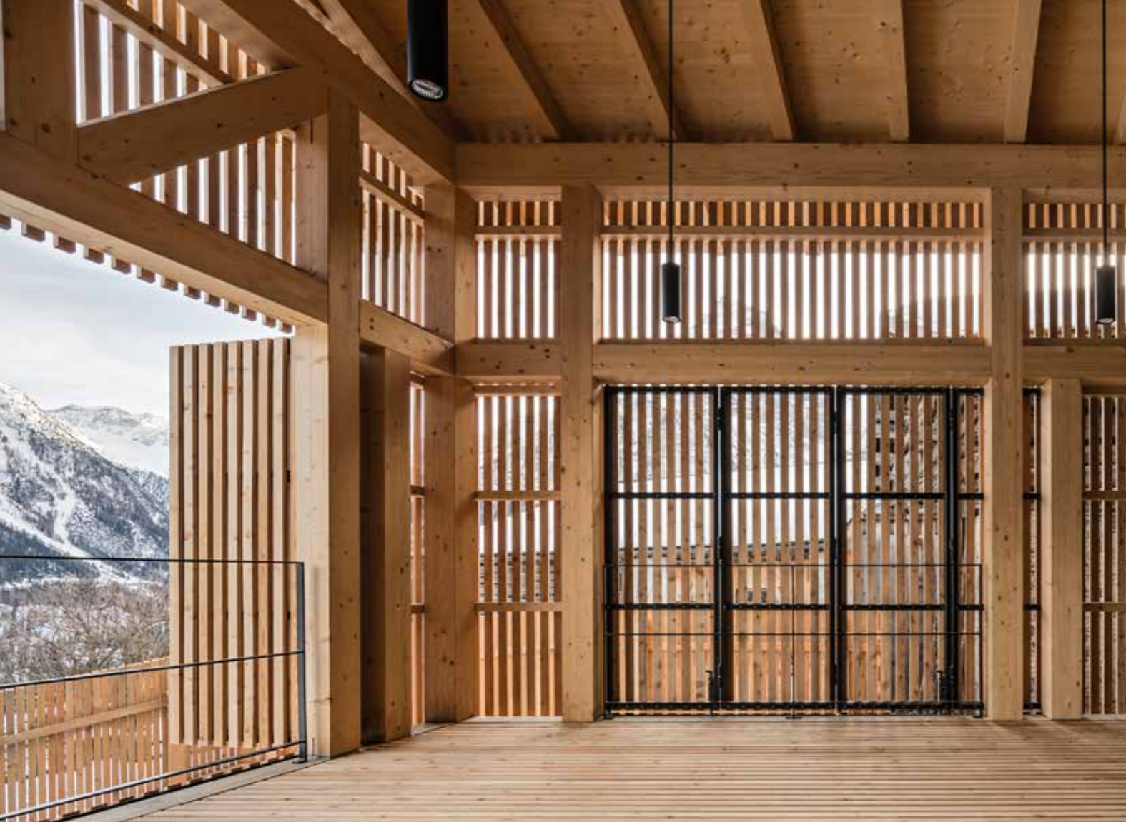
Die Loggia eröffnet den Blick in Richtung Albulatal. Die Falt-schiebetüren wurden aus Lärchenholz gefertigt. Die Lampen hat der Architekt für das Haus mass-geschneidert.
