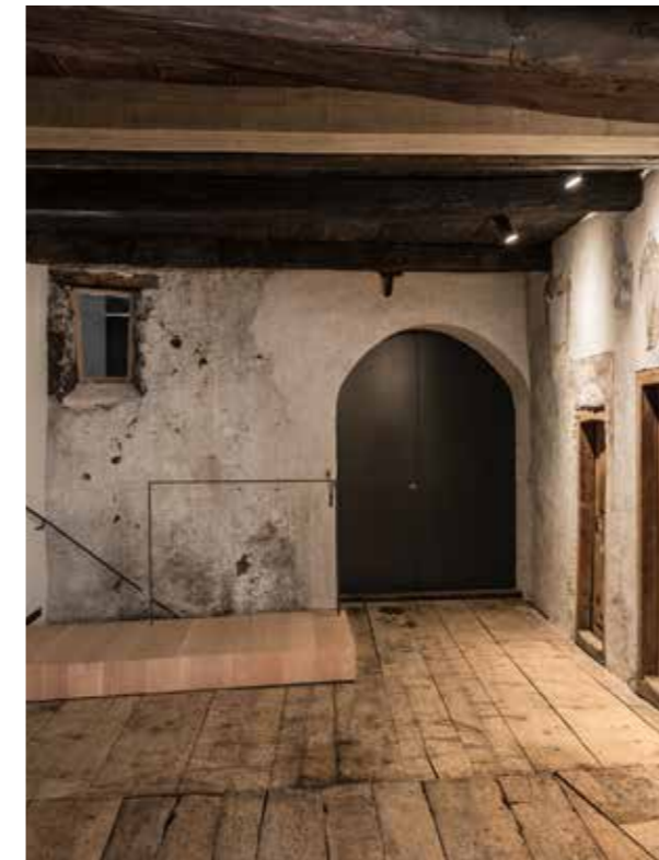
Durch den für Bündner Bauernhäuser typischen sogenannten Sulër führen früher die Wagen, um das Heu in die Scheune zu bringen.
