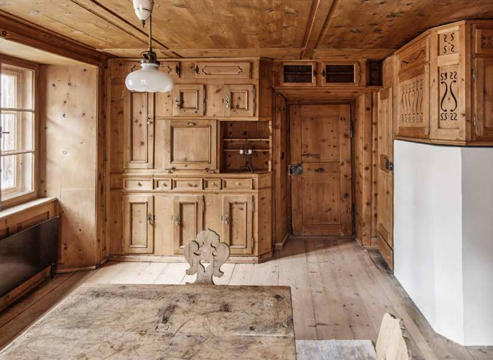
In der alten Stube (Stüva) hat der Schreiner die alten Arven-Holztäfer aufgefrischt und ausgebessert. Der Ofen wurde von den früheren Kacheln befreit und weiss gekalkt. Die schwarzen Radiatoren kamen neu hinzu und markieren den Kontrast zwischen Alt und Neu.
