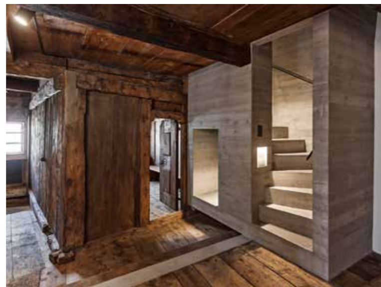
Beim Treppenhaus zur Erschliessung des Schlafgeschosses spielte der Architekt mit dem reizvollen Kontrast von alter Strickbauweise und modernem Betonkern.
